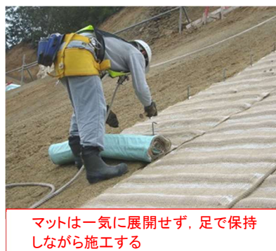
図2. マットの展開・施工方法
