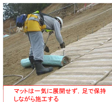
図2. マットの展開・施工方法
