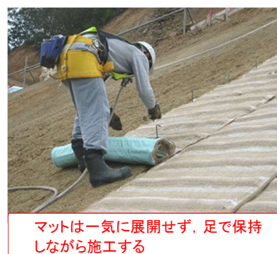
図2. マットの展開・施工方法
