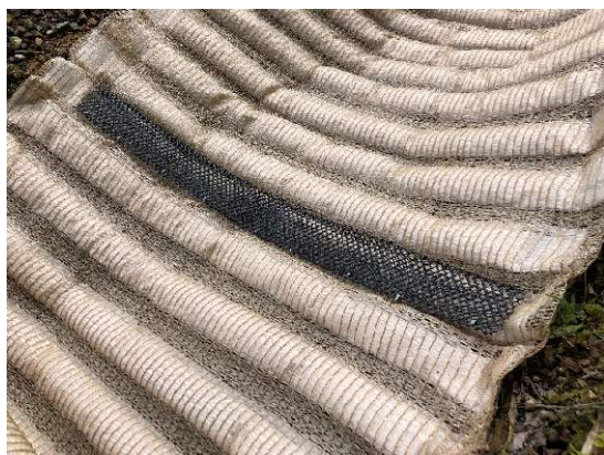
写真 5. マット展開時 しがらが倒れた状態
