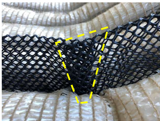
写真 7. 水路底面と側面（斜面）の変化点において（左右 2 ヶ所）、三角形の折り目を付ける
