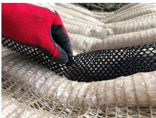
写真 7. 水路底面と側面（斜面）の変化点において（左右 2 ヶ所）、三角形の折り目を付ける
