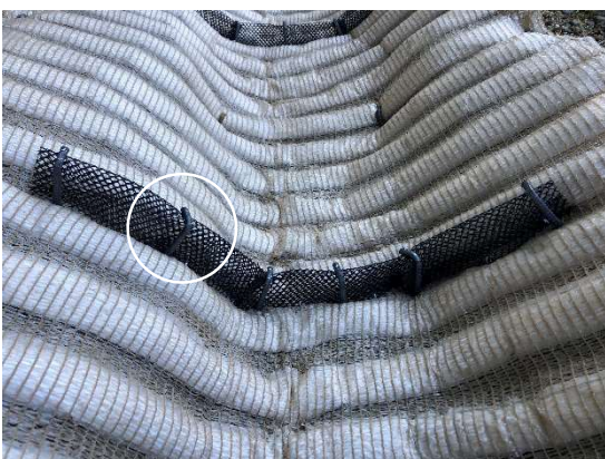
③・④・⑤ しがらの中心・端部の計 3 点 しがらを三角に折り曲げるのは不要 ※）③・④・⑤の順序は不問
