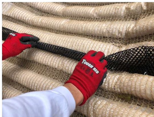
写真 6. しがらを立ち上げる状況 水路勾配に対して 90° 立ち上げる
