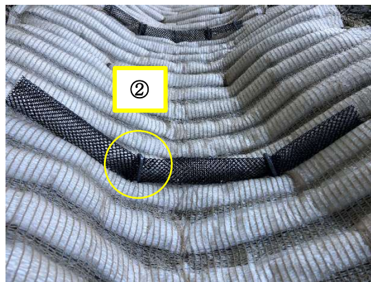
② 他方の 水路底面と側面（斜面）の変化点 ※）①・②の順序は不問
