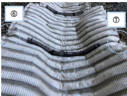
⑥・⑦ マット端部の計 2 点 アンカー類を浮かせるのは不要 ※）⑥・⑦の順序は不問
