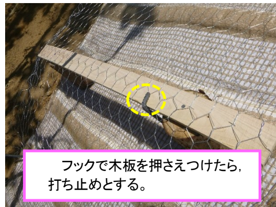
写真-8. アンカーピン打設完了
