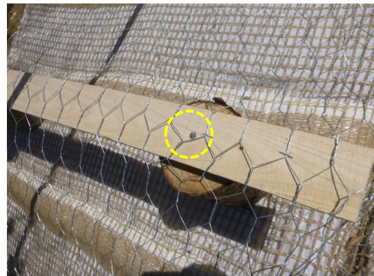
写真-5. 丸釘の打設完了
