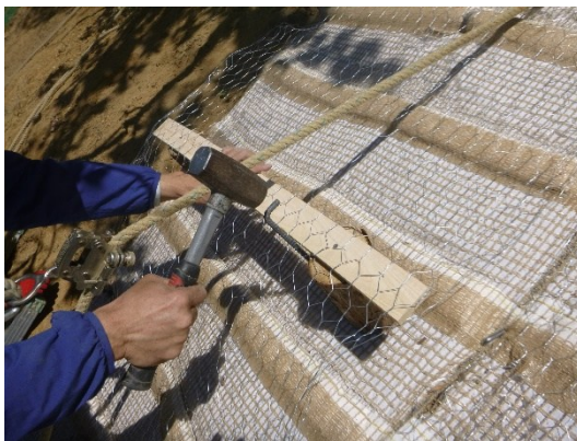
写真-7. アンカーピン打設状況
