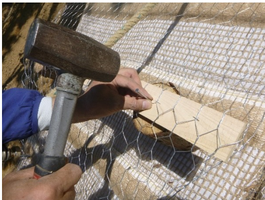
写真-4. 丸釘の打設状況
