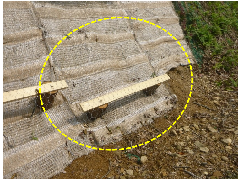
法尻部の調整①：凸型形状を設けた例
