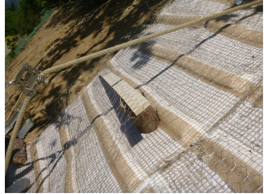
写真-2. 丸太配置完了
