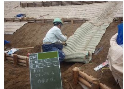
図 1. マット施工状況
