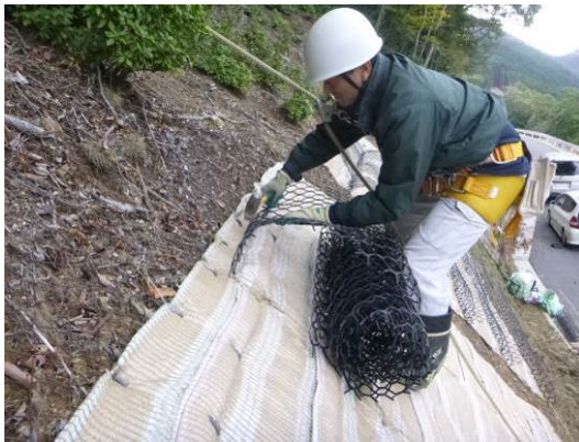
写真-4. 上端部の打設方法
