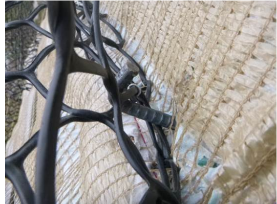
写真-14. 接続部のアンカー打設方法
