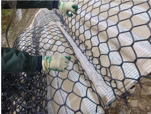
写真-14. 接続部のアンカー打設方法
