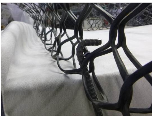
写真-12. 法面下方から見た状況
