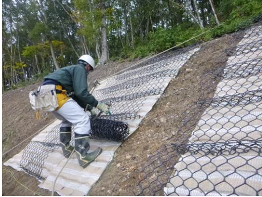
写真-3. アーチブロック展開方法
