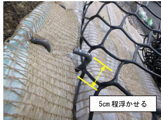
写真-5. 上端部の打設状況
