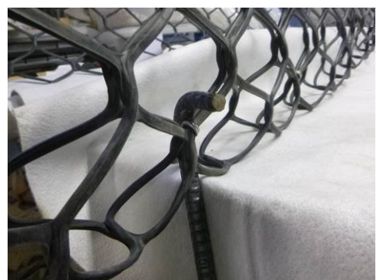
写真-13. 法面上方から見た状況
