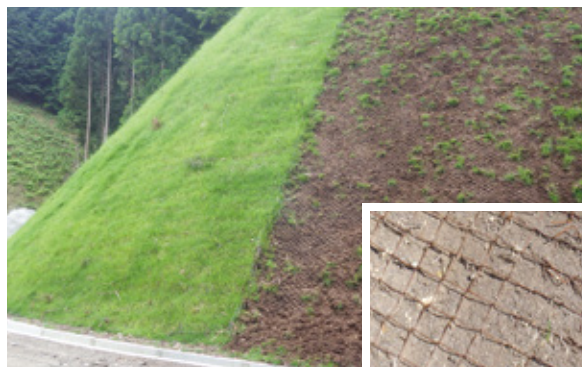
シカノン + ガンリョクマット 植生基材吹付工 (ラス金網)
