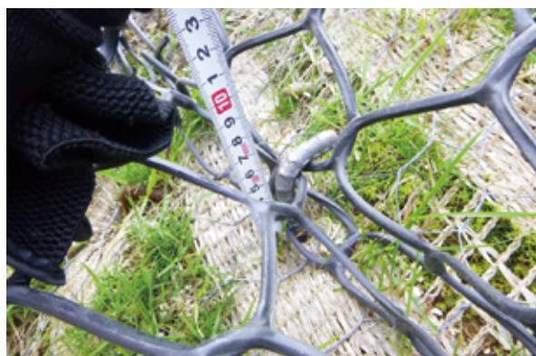
アンカー打設状況
