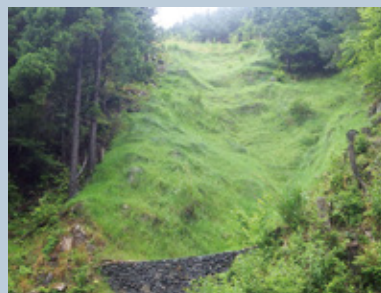
施工後 2 年 5 ヶ月
