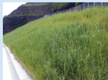
施工後 1年4ヶ月
