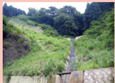
施工後1年6ヶ月
